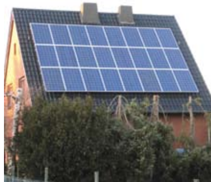
Casa en Alemania con paneles fotovoltaicos, capaz de generar 3 a 4 KW.
