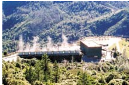
Planta Geotermoeléctrica The Geysers California.
