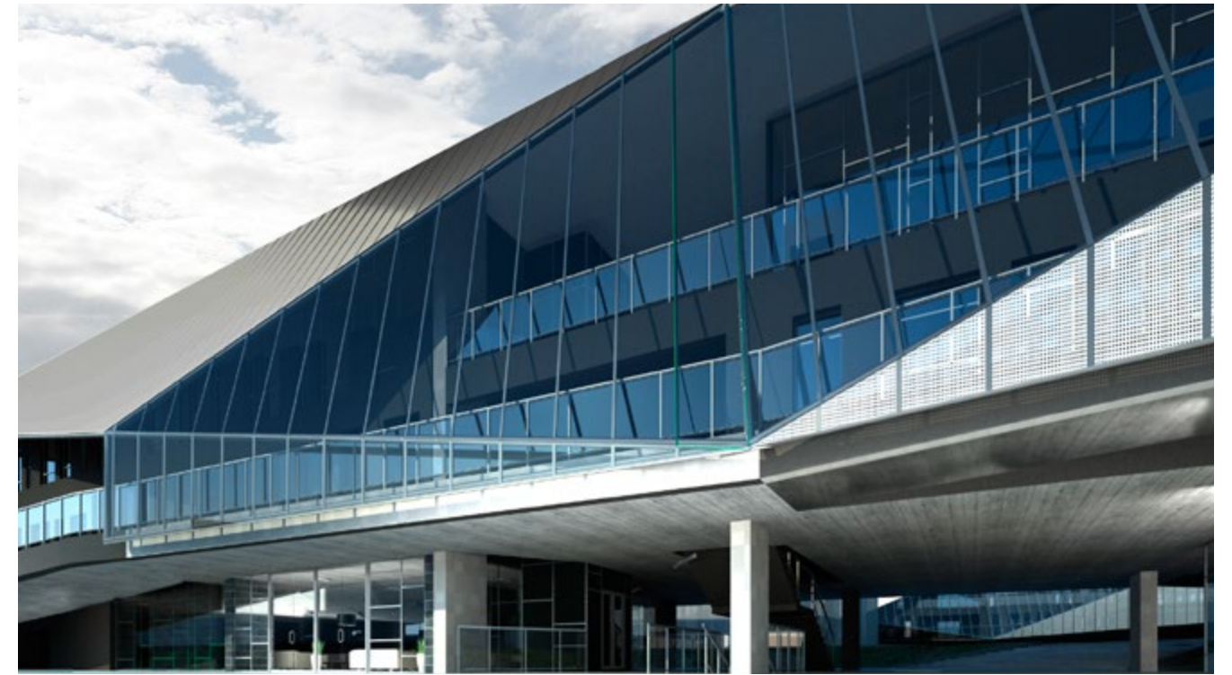
Estos edificios contarán con la más alta tecnología en climatización, iluminación y acústica.
